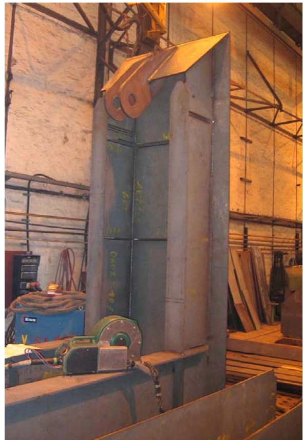
Abb. 2.2: Aufsetzen der vertikalen Rahmen
